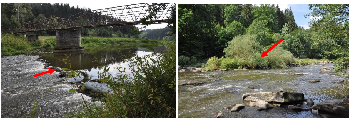
Obr. 42: Stupeň v korytě na začátku úseku Stvořidla (vlevo) a korytová akumulace s vegetačním porostem v úseku Stvořidel (vpravo) (21. 8. 2015).
