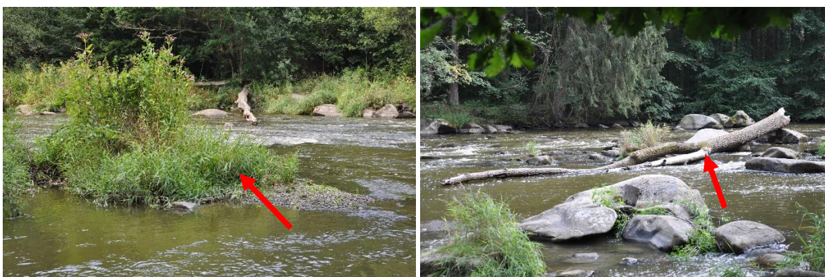
Obr. 43: Korytová akumulace (vlevo) a překážka v korytě - kmen (vpravo) v úseku Stvořidla (21. 8. 2015).
