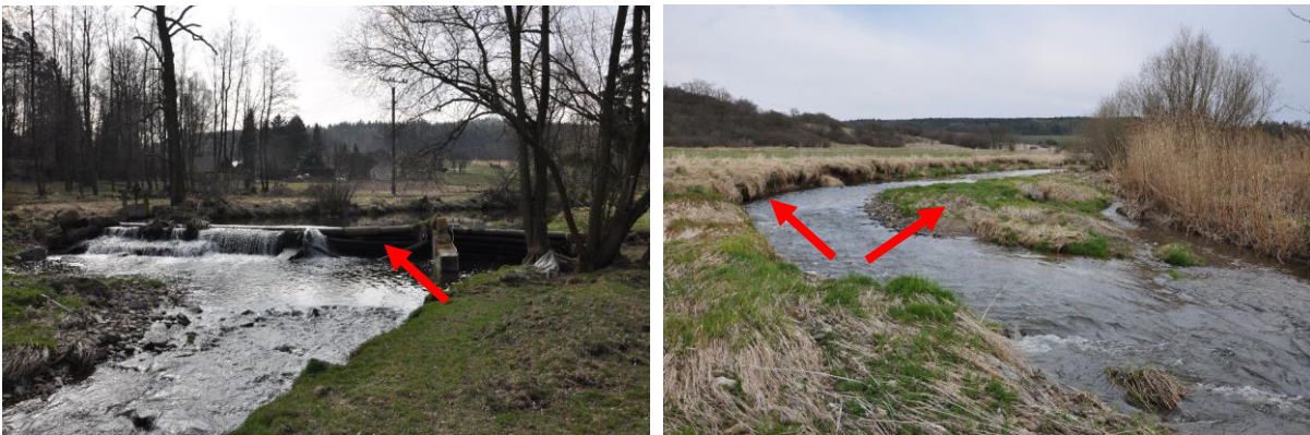
Obr. 54: Poškozený jez u Medalova mlýna (vlevo) a břehová nátrž s erozně odříznutou částí břehu a korytovou akumulací u Dominikálních Pasek (vpravo)(10. – 11. 4. 2015).
