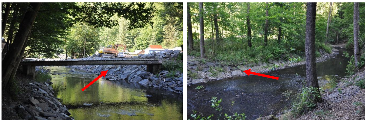
Obr. 67: Pohled na začátek souvislé úpravy Kocáby od ústí Královky k ústí Kocáby do Vltavy (vlevo) a začátek úseku mapování, kde je koryto místy zpevněno kameny cca 100 m (vpravo) (3. 7. 2015).
