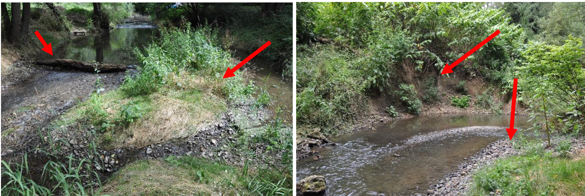
Obr. 82: Korytová akumulace s kládou vytvářející překážku v korytě (vlevo) a břehová nátrž při výsepním břehu s protilehlou korytovou akumulací (vpravo) poblíž lokality V Kozli (29. 7. 2015).
