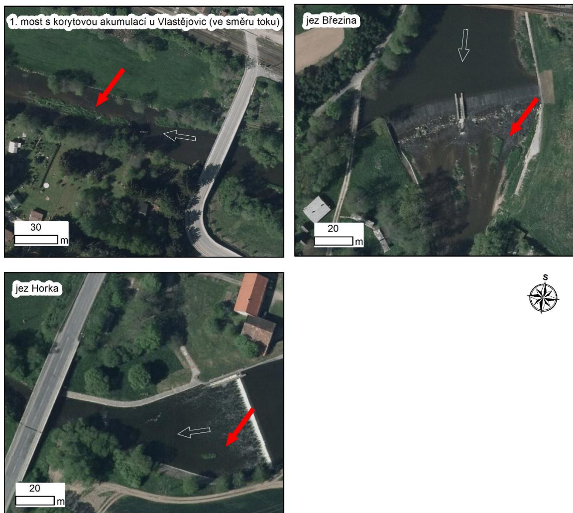
Obr. 47: Jezy a korytové akumulace v úseku Ledeč nad Sázavou - Zruč nad Sázavou. Pozn.: Bílá šipka ukazuje směr toku a červená šipka poukazuje na umístění korytové akumulace. Letecké měřičské snímky ČÚZK (2015).
