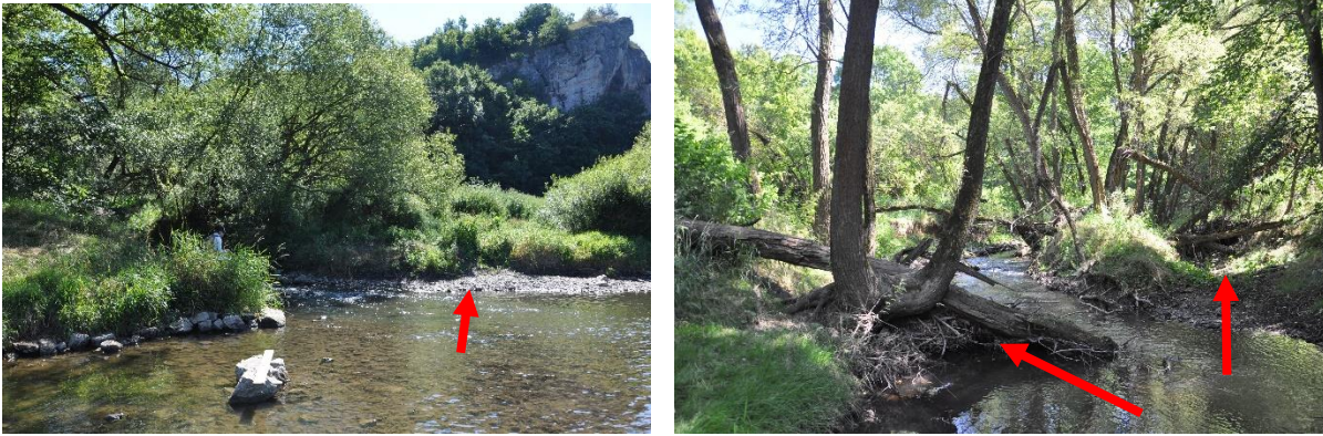
Obr. 81: Ústí Loděnice do Berounky s korytovou akumulací (vlevo) a závaly dřevní hmoty s náznakem povodňového koryta vpravo před lokalitou V Kozli (vpravo) (29. 7. 2015).
