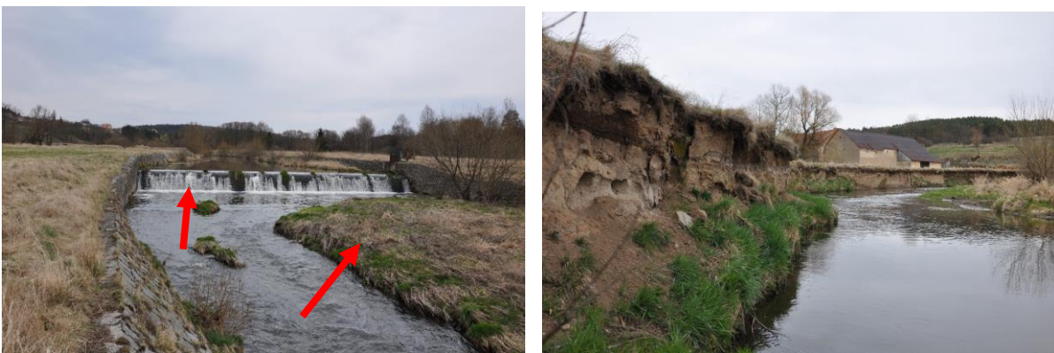
Obr. 55: Jez u Pičinského mlýna s velkou korytovou akumulací pod ním (vlevo) a dlouhá břehová nátrž u Pičinského mlýna (vpravo) (11. 4. 2015).
