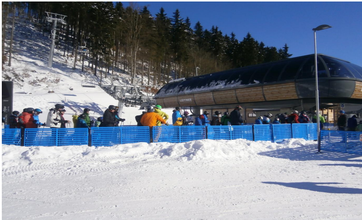
Příloha č. 45: Nástupní část lanovky A ze Pstruží na vrchol Plešivce
