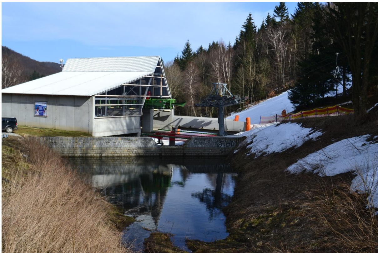
Příloha č. 50: Lyžařský areál Telnice - spodní stanice lanovky a vodní nádrž určená pro tvorbu technického sněhu
