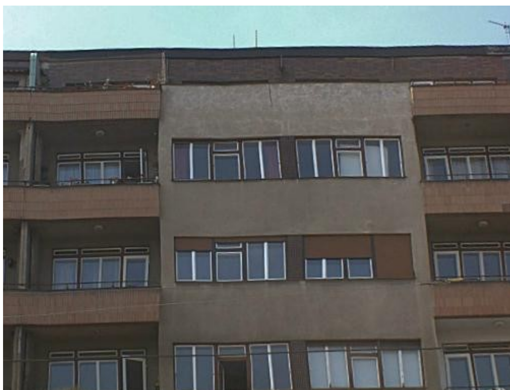
Obr 26: Objekt Milady Horákové 848/90 byl postaven jako dvojdům, trhliny se objevily na obou částech objektu, zde trhlina na západní části domu. Archivní snímek z jara 2014 (Google)
