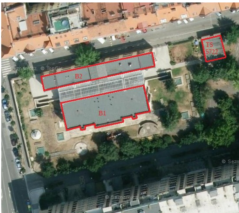
Obr 5 dole : Letecký snímek na areál Mateřské školy Na Výšinách 3/1075 s vyznačenou pozicí učební budovy (B1), hospodářské budovy (B2) a trafostanice TS 5722 (Mapy.cz)
