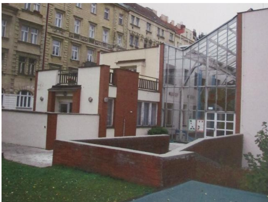
Obr 7 : Pohled na objekt Na Výšinách 3/1075 na západní část budovy B2 a atrium (stav léto 2008, archiv MŠ Na Výšinách)
