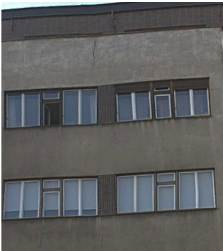
Obr 26: Objekt Milady Horákové 848/90 byl postaven jako dvojdům, trhliny se objevily na obou částech objektu, zde trhlina na západní části domu. Archivní snímek z jara 2014 (Google)
