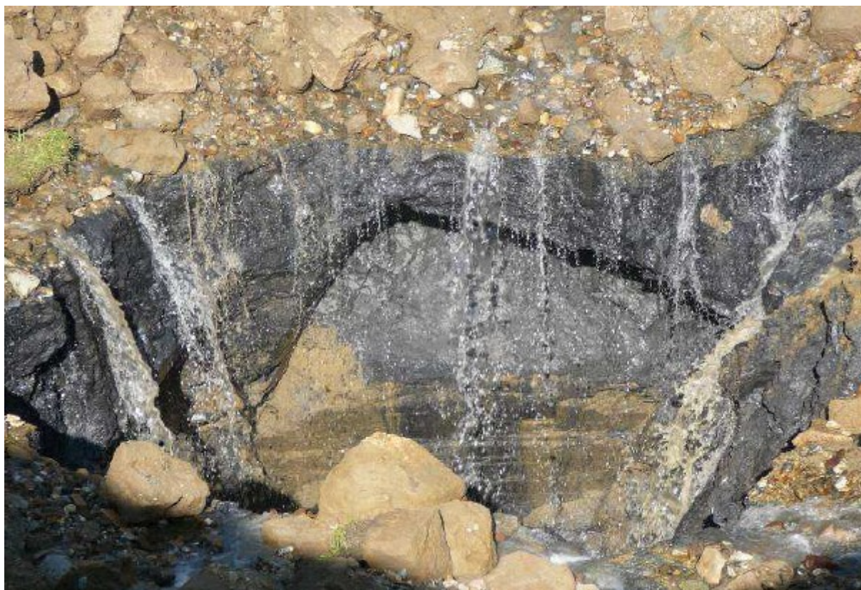
Obr 19: Přítoky vody z kvartérních sedimentů do otvoru vzniklého propadem v km 6,052 (Barták J., 2010). Snímek je výbornou ukázkou vysoké propustnosti kvartérních uloženin v dolní části Stromovky. Do místa havárie přitéká z kvartérních sedimentů více než 10 litrů vody za sekundu.
