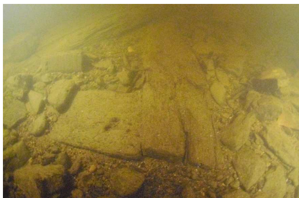
Obr. 75: Dřevěný základový rošt jednoho z pilířů Juditina mostu – podle Státníková 2013.
