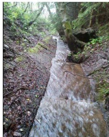
Obr. 37 a 38 Vlevo dřevní akumulace vytvářející hlubinný úsek na antropogenně ovlivněném toku, vpravo souvislé betonové opevnění. Zdroj: vlastní fotografie
