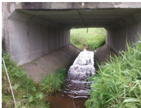
Obr. 41 a 42 Vlevo úprava břehu vložení kamenů a vpravo betonový propustek pod mostem se silnicí. Zdroj: vlastní fotografie
