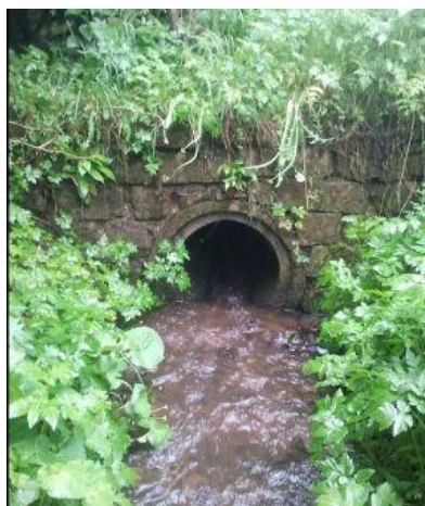
Obr. 39 a 40 Vlevo zatrubnění toku pod hospodářskou komunikací, v mapě značeno jako úsek č. 12. a vpravo minimální zahloubení toku ve střední části. Zdroj: vlastní fotografie
