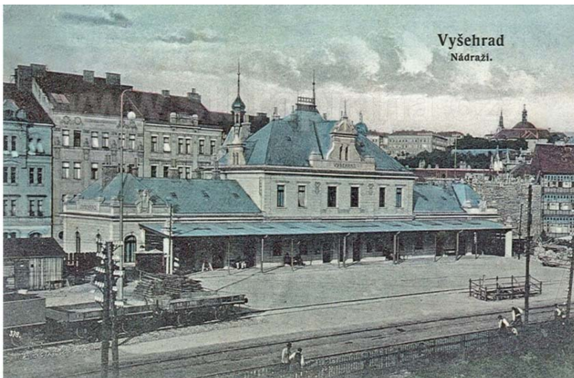
Obrázek 5: Nádraží budova na staré pohlednici
