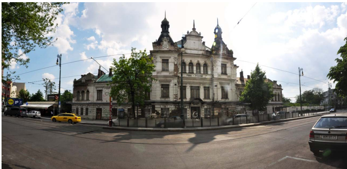
Obrázek 8: Současný stav nádraží Vyšehrad
