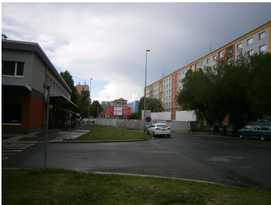
Obr. č. 5 – Okolí budoucí stanice metra A Petřiny
