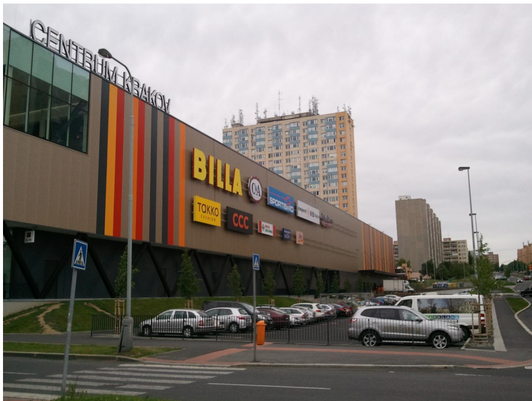
Obr. č. 9 – Okolí Kulturního domu Krakov v Bohnicích
