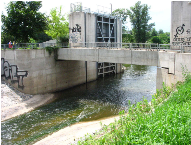
Obr. 5 Protipovodňová vrata při ústí Rokytky
