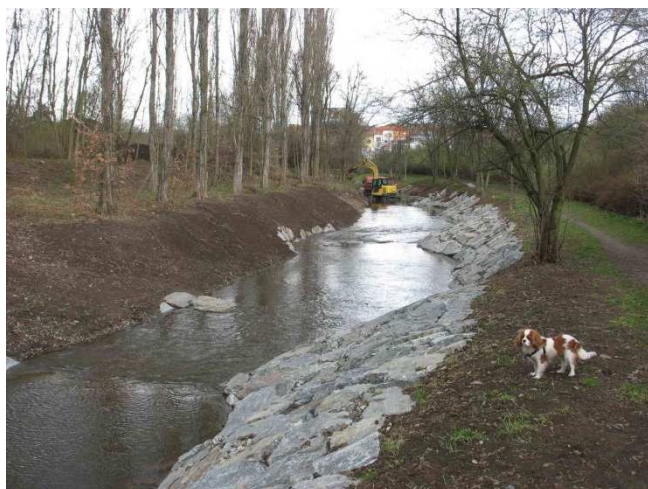
Obr. 20 Průběh úpravy koryta Rokytky (nahore bagr), nepravidelné břehy Zdroj: foto vlastní, březen 2014
