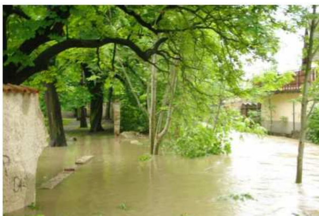
Obr. 83 Probořená zeď zámeckého parku v Počernicích
