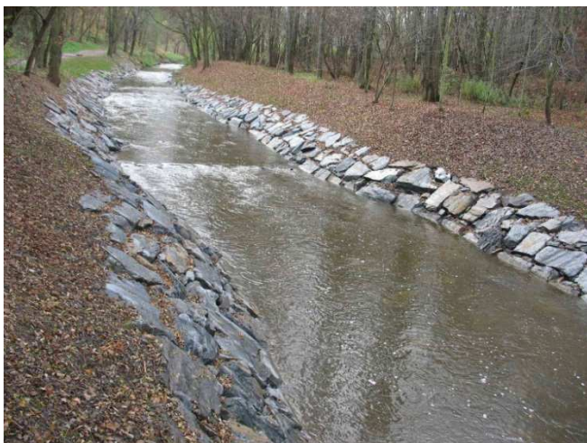
Obr. 19 Kamenem upravené koryto Rokytky Zdroj: foto vlastní, listopad 2013
