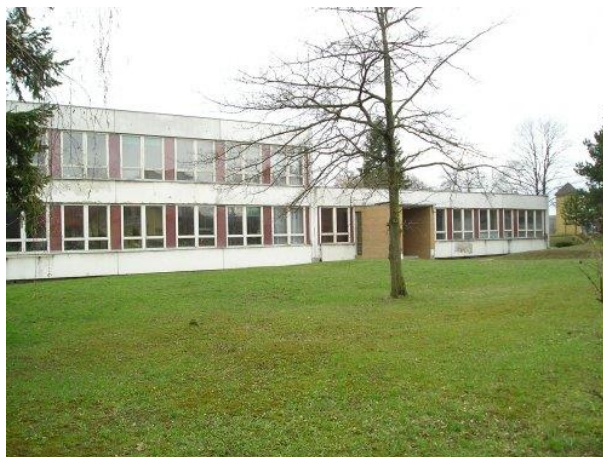
Obrázek 12: Přístavba - pohled ze severní strany
