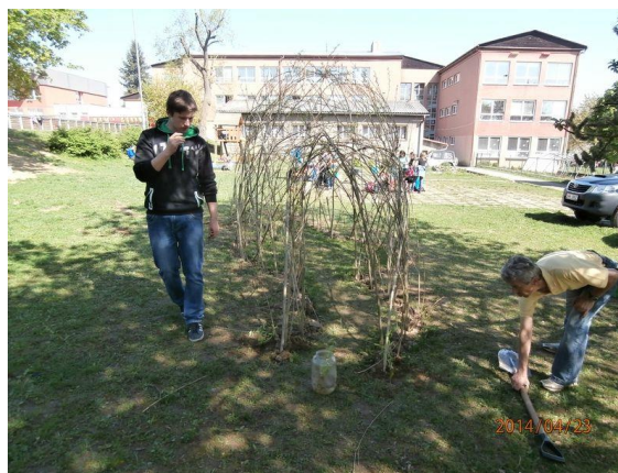
Obrázek 59: Budování vrbového tunelu
