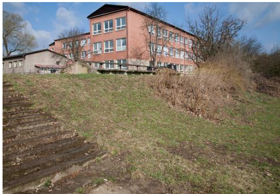
Obrázek 36: Zahrada před rekonstrukcí
