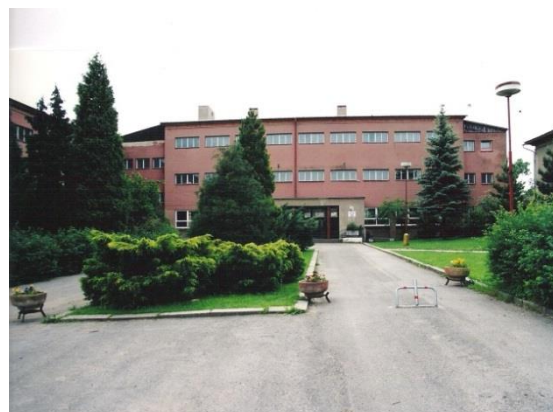
Obrázek 5: Hlavní vchod - r. 2000
