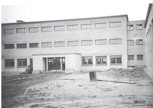
Obrázek 4: Hlavní vchod - r. 1958/
