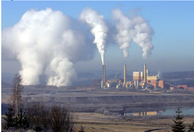
Tepelná elektrárna Tisová
