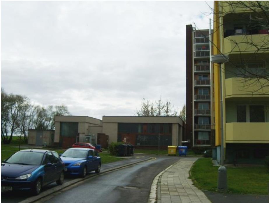
Obr. 4: Plynová kotelna PK3 (Autor obr.: Eliška Čejková)
