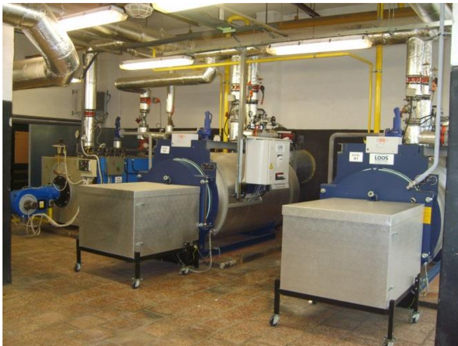
Obr. 5: Plynové kotle, zprava K1, K2 a K3 (Autor obr.: Eliška Čejková)
