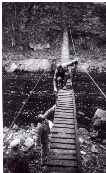
Obrázek 18. Stavba lávky na Kančí louku. LUCAN: Trampská historie řeky Oslavky. Padochov: Oslavské boudy, 2004, s. 41.
