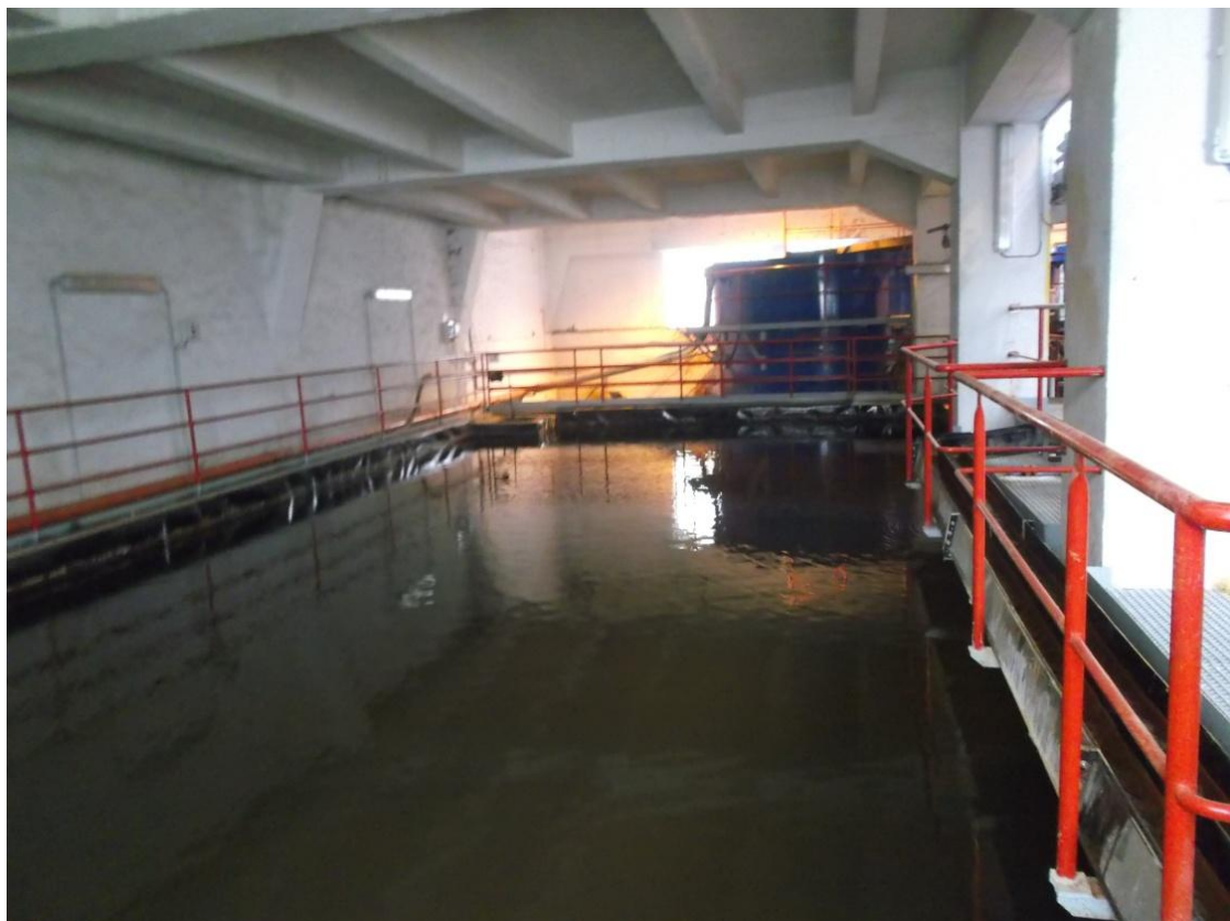
Obr. 8: Vnitřní sedimentační nádrž; po stranách vyrostlice sádrovce
