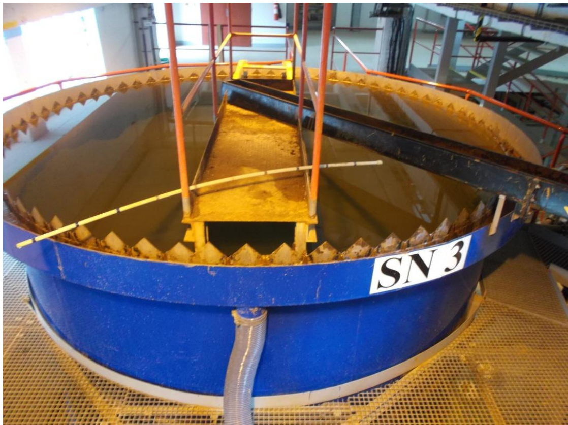
Obr. 8: Vnitřní sedimentační nádrž; po stranách vyrostlice sádrovce
