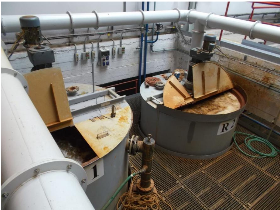
Obr. 6: Pohled na neutralizační nádrže R1a R2 – odběrná místa VZ.3 a VZ.4
