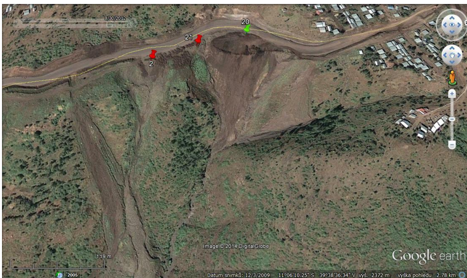
Obrázek 34: Odlučná hrana sesouvání a stékání v zářezech silnice
