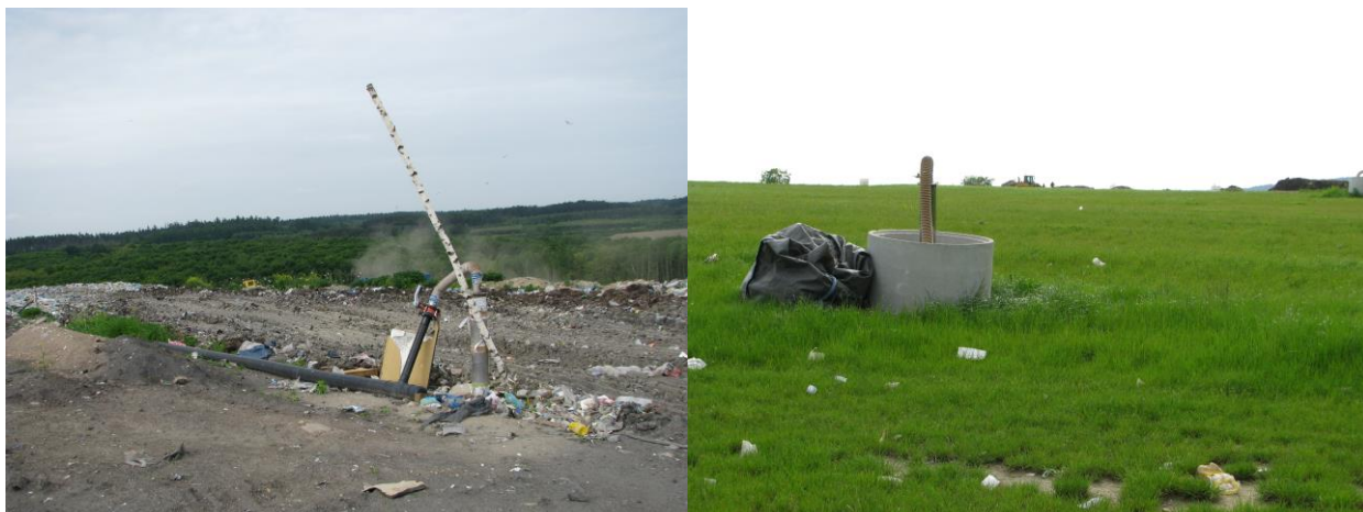
Obr. 6: Jímání skládkového plynu v areálu skládky Chvaletice (Zdechovice); první foto – aktivní část skládky, druhé foto – rekultivovaná část s plynovými studnami
