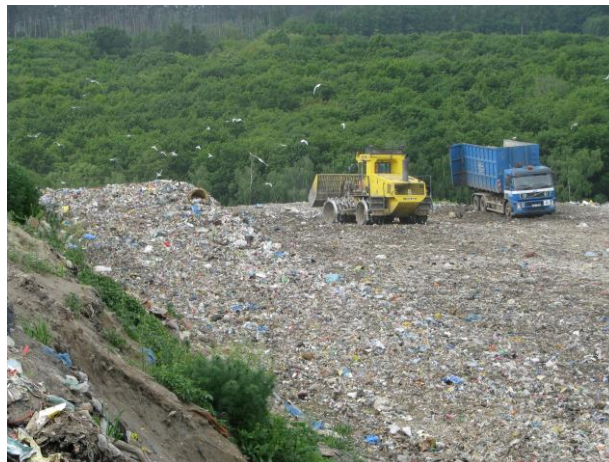
Hutnění nově navezeného odpadu a tvoření svahů
