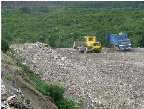
Hutnění nově navezeného odpadu a tvoření svahů
