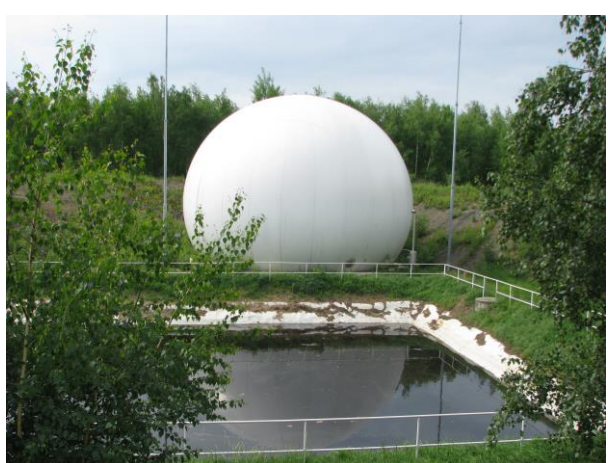
Plynojem, předním retenční jímka
