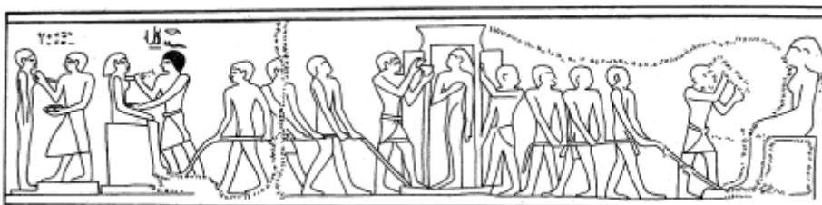
38. Znárodnění sochařské dílny v Cejově hrobce, severní Sakkára
