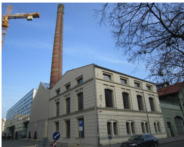
Obrázek 9: Revitalizované budovy bývalých budov ČKD. Uprostřed bývalá kotelna s komínem, vpravo Machine House.
