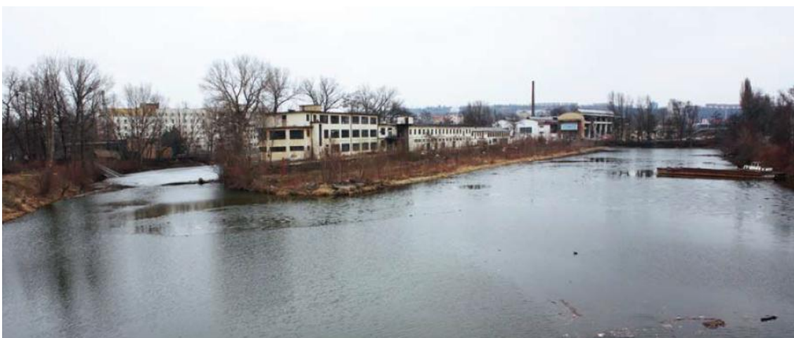
Obrázek 19: Loděnice Praga těsně před demolicí budov, pohled od ústí Rokytky, 2010. Zdroj: Holešovický a libeňský přístav, s. 42.
