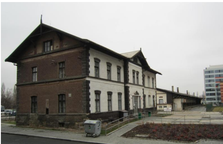
Obrázek 3: Bývalá drážní budova na Rohanském ostrově.
