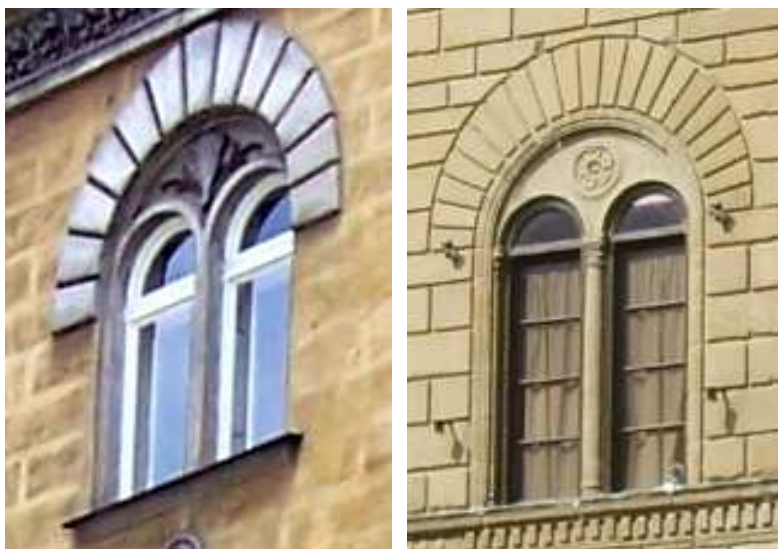
15) Detail okna na činžovním domě ve Slezské ulici, Praha 16) Detail okna na Palazzo Medici-Riccardi, Florencie
