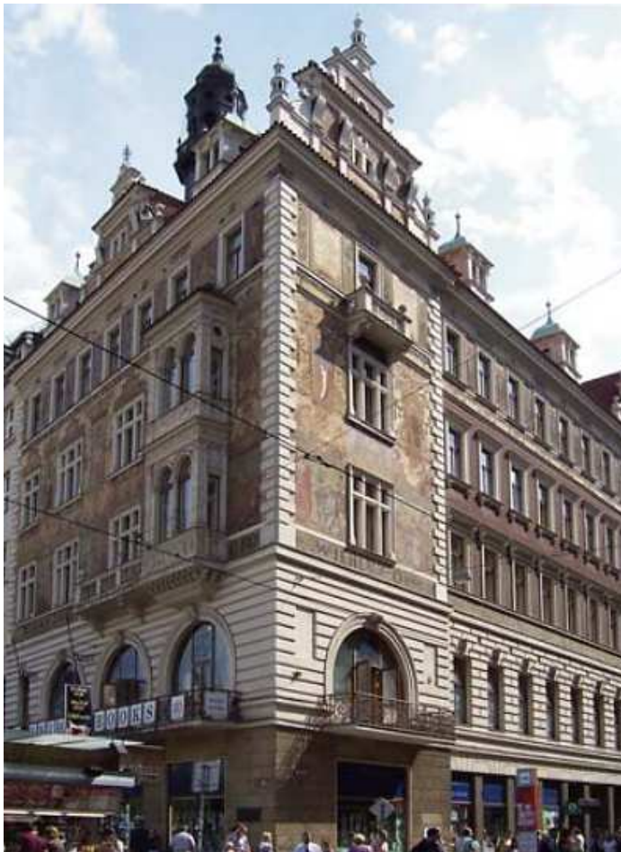
92) Wiehlův dům, Praha
