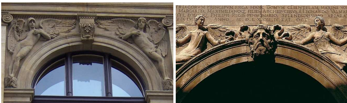
91a) Detail průčelí České spořitelny, Rytířská ulice, Praha 91b) Detail průčelí Palazzo Valmarana, Vicenza
