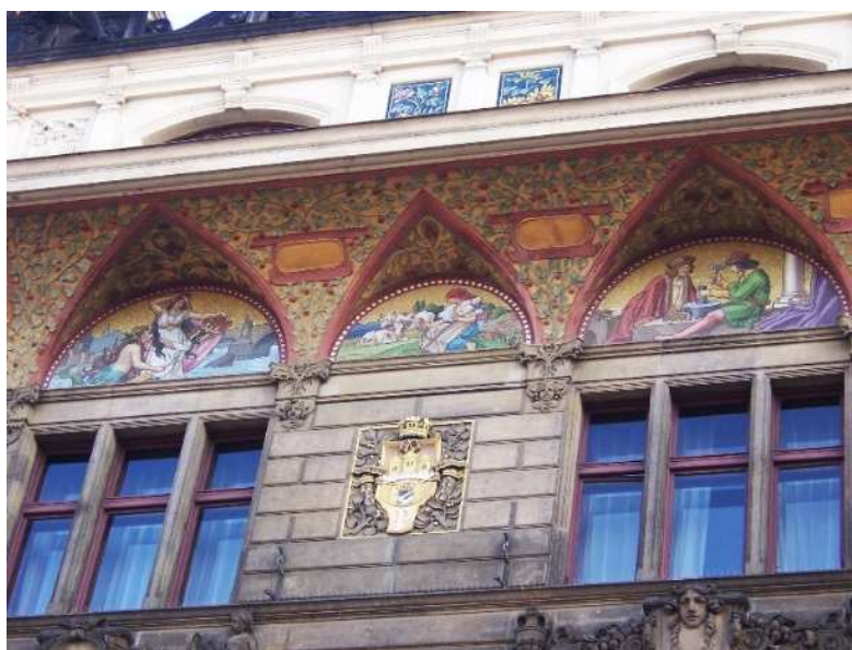
28) Zemská banka, Na Příkopě 20/858, Praha
