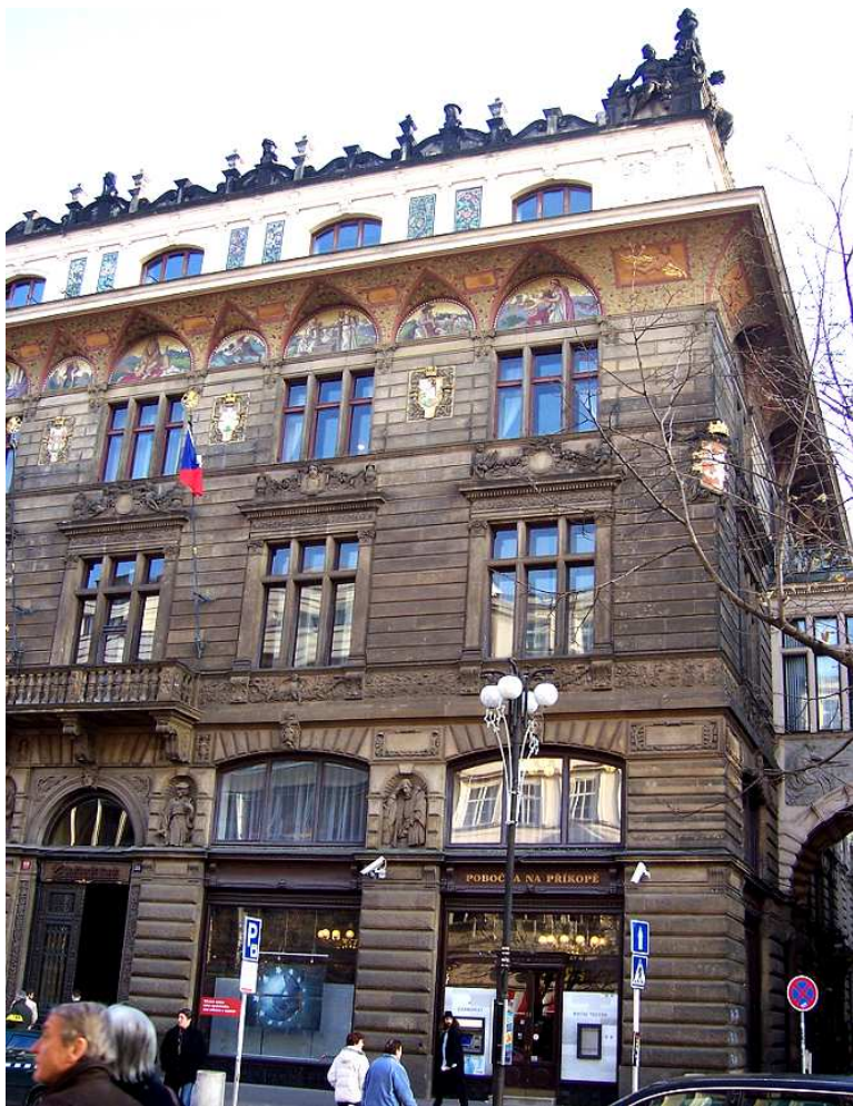
27) Zemská banka, Na Příkopě 20/858, Praha
