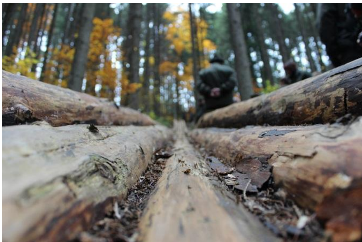
Obr. č. 22: Dřevěný žlab určený k transportu dřeva, Čierny Balog 2012, foto A. Smrčka.
