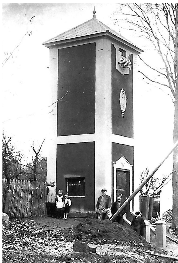
Transformátor pod hradem, vystavěný Hynkem Posltem r. 1923.
