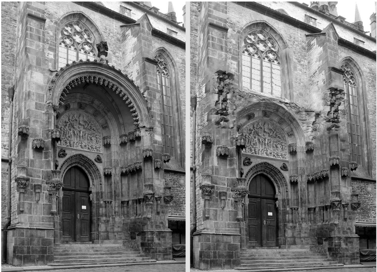
Praha, chrám Matky Boží před Týnem, severní portál, pokus o rekonstrukci situace z konce 14. st, kdy nebyla předsíň portálu zaklenuta (foto 2)
