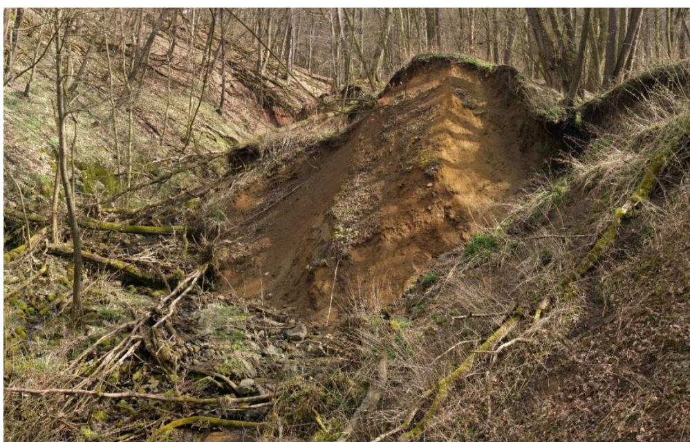
Obr. 12 - Čelo akumulácie zosuvu erodované a destabilizované bočnou eróziou potoku Rytina (FOTO AUTOR, 2014)
