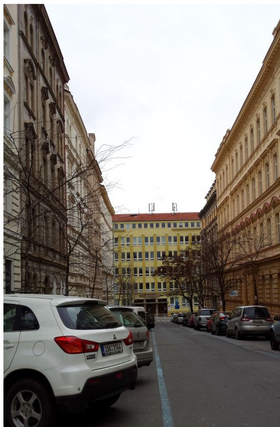
Obrázek 13: Dnešní pohled z Moravské ulice. V pruhu Základní škola a gymnázium Sázavská.
