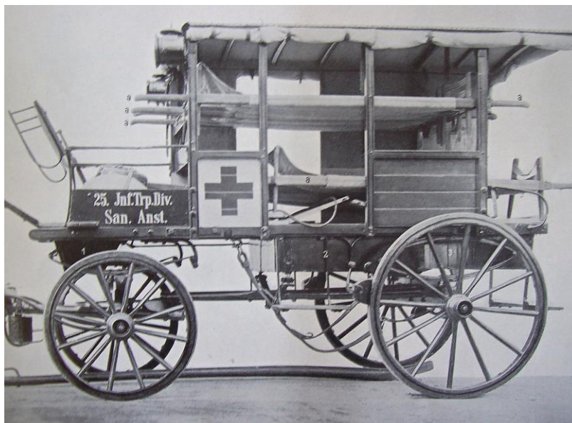
Obr. 20: Nejnovější typ hipomobilního lůžkového vozu pro raněné (k roku 1904), rakousko-uherská armáda. Zdroj: VÚA-VHA Praha, fond Rakouské předpisy. C-2. Trainunterricht. Figurenheft zum I. und II. Teil, Vídeň 1904.
