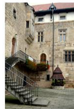
schodiště s dnešním hlavním vstupem
