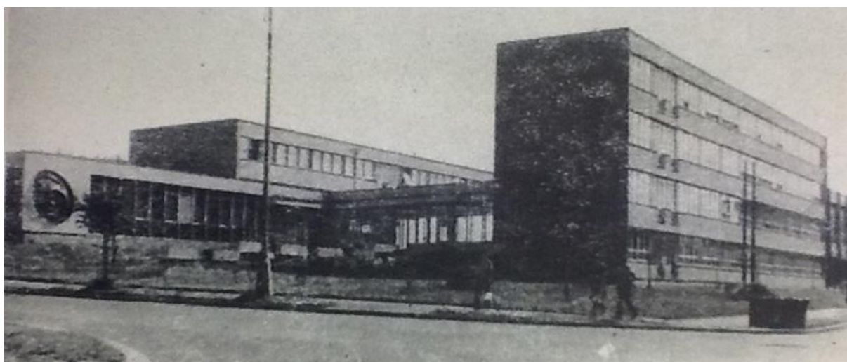
Současná budova, foto z roku 1973, Kronika 1973-1996
