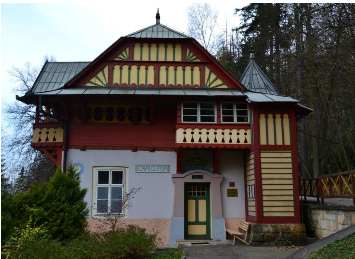
22. Luhačovice, Chaloupka, čelní stěna
