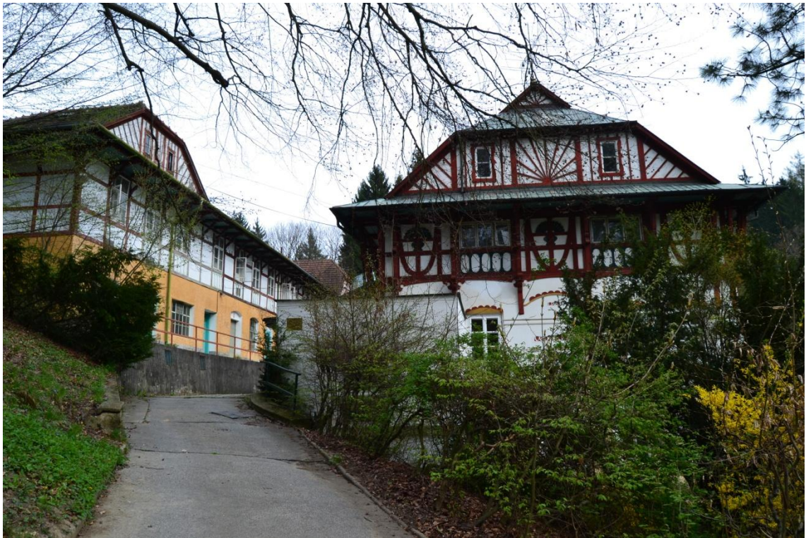
25. Luhačovice, Vodoléčebný ústav
