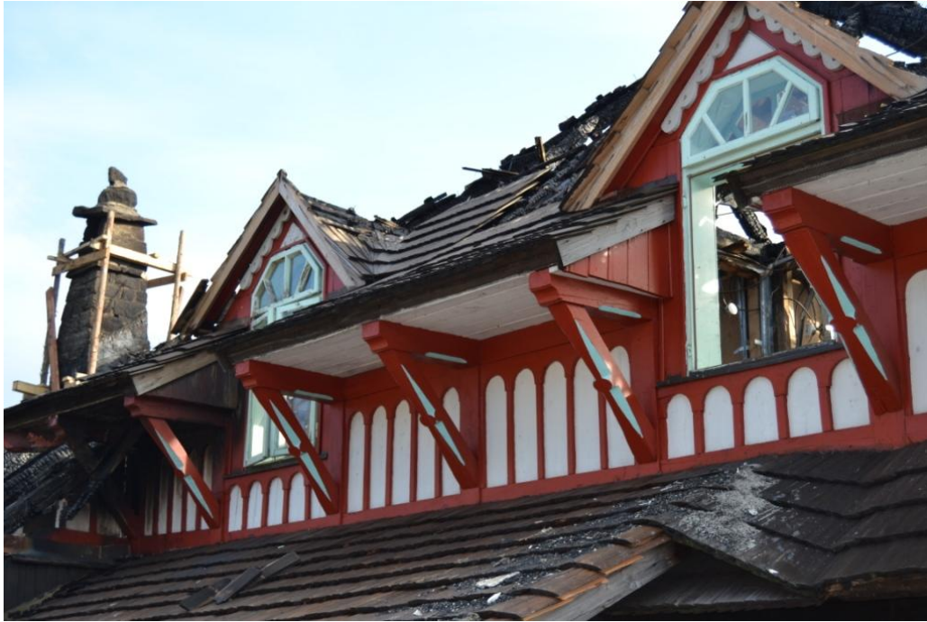
17. Pustevny, detail střechy jídelny Libušín
