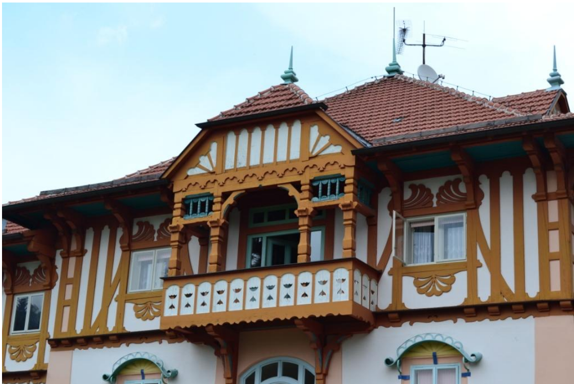
20. Luhačovice, detail fasády s arkýřem
