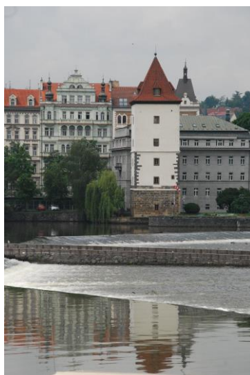
10. Věž Petržalkovské vodárny
