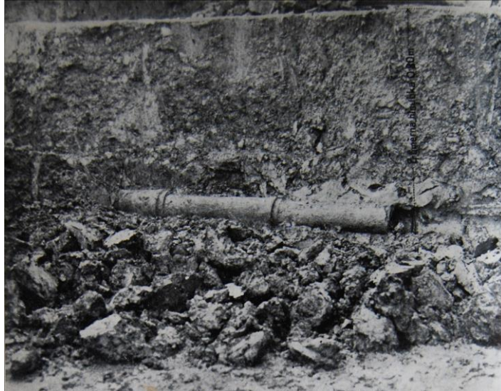
3. Potrubí z pálené hlíny vodovodu z Veleslavína na Pražský hrad, objeveno roku 1924
