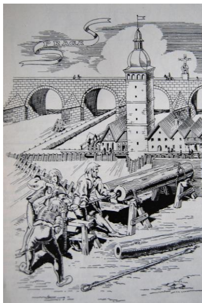
9. Vrtání dřevěných trub v 18. století
