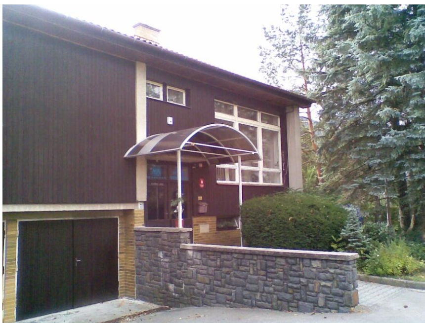
Obrázek č. 11 – SOS dětská vesnička Chvalčov – hlavní budova
