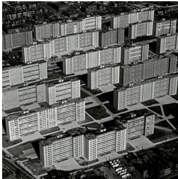
Sídliště Pruitt-Igoe, St. Louis, Missouri, USA (zdroj: Internet)
