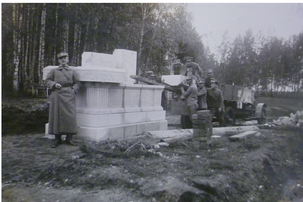
Příloha č. 19: Stavba pomníku padlým československým dobrovolcům 8. střeleckého pluku
