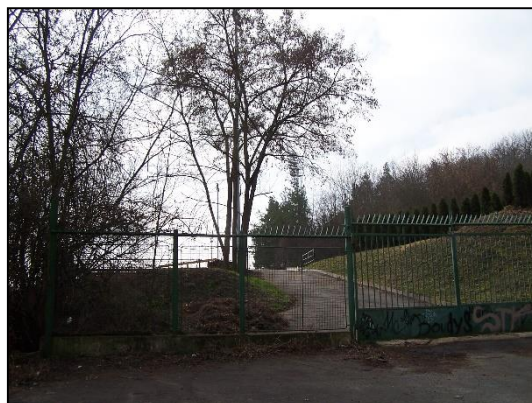
Obr. 71: Pohled ke stadionu Juliska z ulice Paťanka
