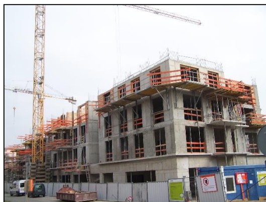
Obr. 80: Výstavba obytných budov na místě bývalé podbabské sladovny
