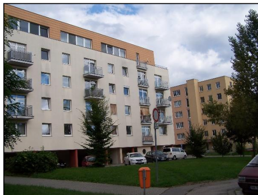
Obr. 112: Novostavby na místě bývalé cihelny na Baních
