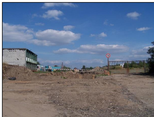
Obr. 109: Sklárky a staveniště na místě bývalé Beranovy cihelny
