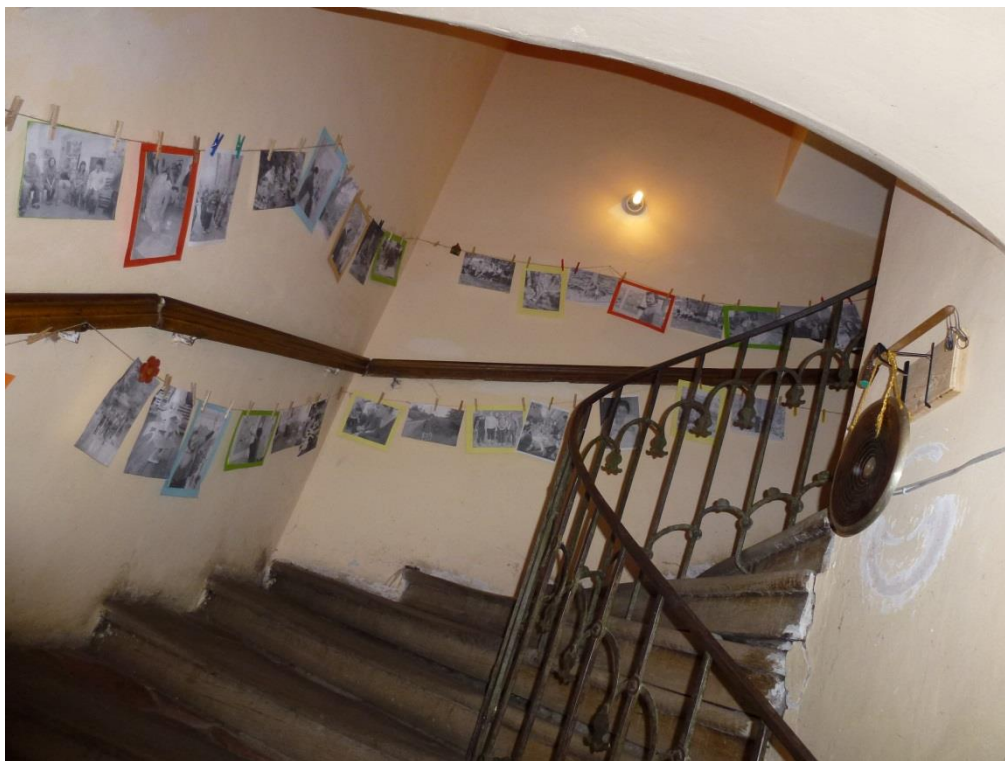
Obrázek č. 22 SCHODY
