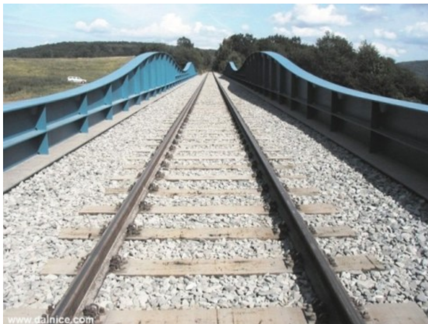
Obrázek 2.1: Sbíhající se koleje.
