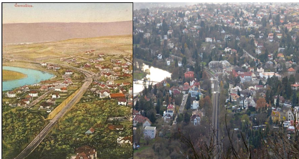
Obr. 3 Pohled na železniční trať v Černošicích. Dostupné z http://fotohistorie.cz/Stredocesky/Praha-zapad/Cernosice/Default.aspx ; archiv autorky.
