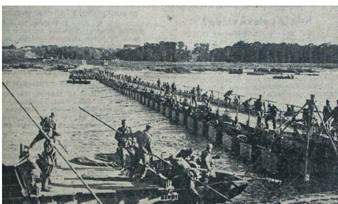
◀ Při přechodu přes Vislu, vyznamenaly se ženijní jednotky říšské branné moci, které vidíte při stavbě pontonového mostu ČTK, Venkov, 13. 9. 1939, roč. 34, č. 214, s. 1
