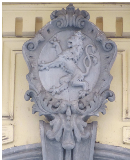
m) Detail portálu domu čp. 313
