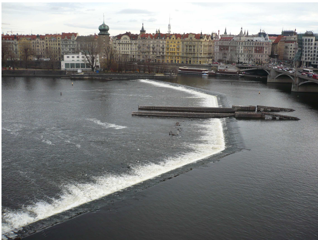
Obr. 28: Celkový pohled na šitkovský jez s vorovou propustí uprostřed, v pozadí komorové plavidlo u Slovanského ostrova Fotoarchiv autora (foto z 23. 12. 2013).
