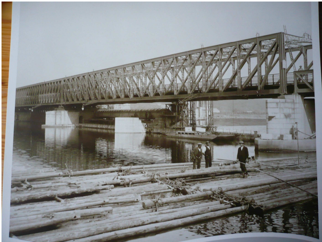
Obr. 8: Pohled na most s nově instalovaným válcovým jezem miřejovického zdymadla v roce 1924 Kalendář Povodí Vltavy na rok 2013, Prosinec 2013.
