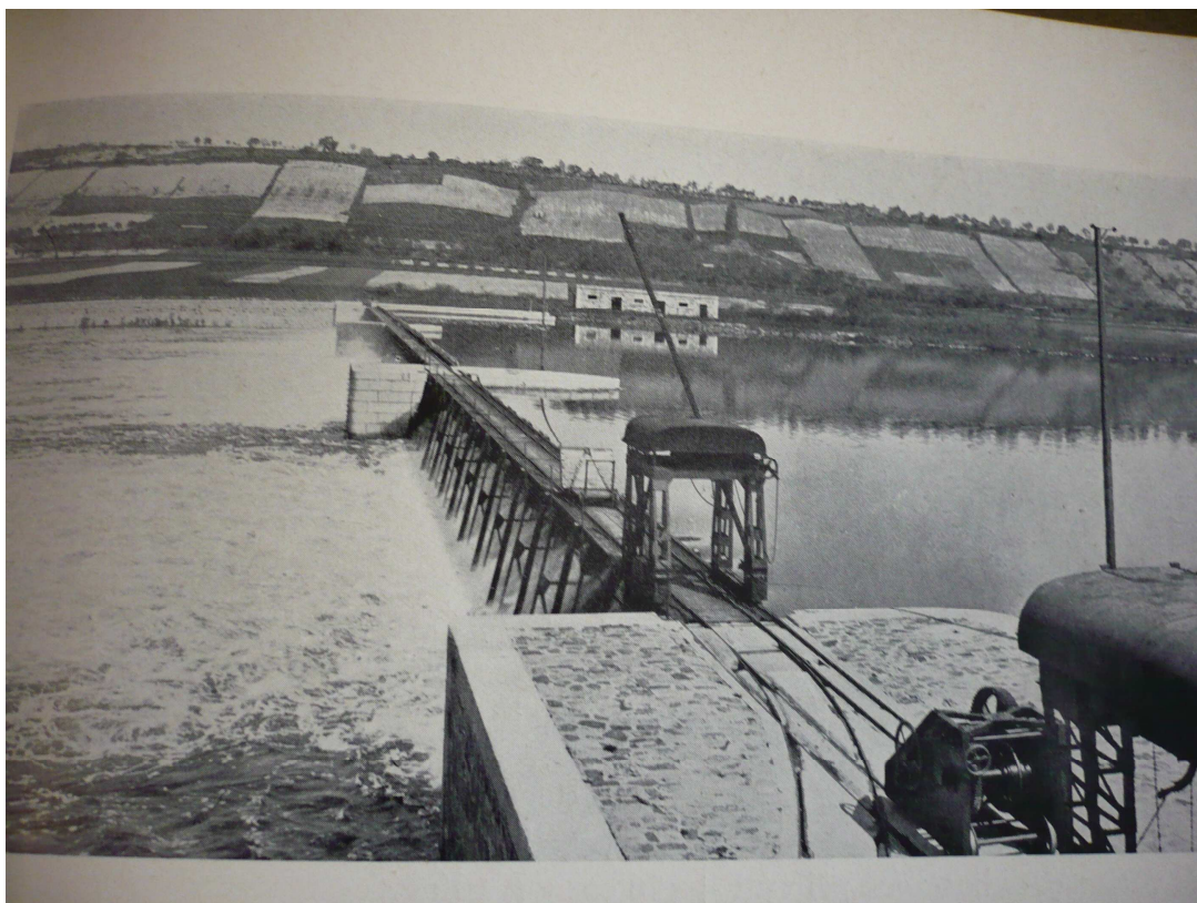
Obr. 17: Detail levého pole kombinovaného stavidlového a hradlového jezu litoměřického zdymadla v roce 1914 Žákavec, Th., Lanna, s. 107.
