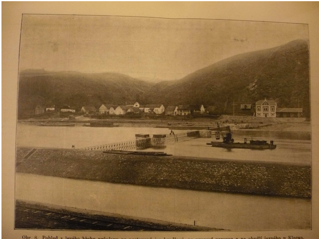
Obr. 8. Pohled z levého břehu příplavu na postavený jez hradlový na průmysl vyrovnat a na obydlí jezného u Klecan.
