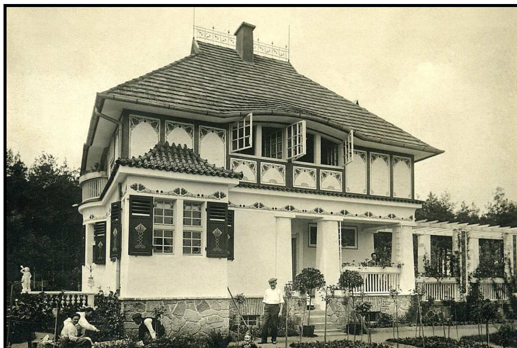
Obr. č. 16 Vila č. p. 50 stávala na rohu ulic Lovčické a Voňkovy.
