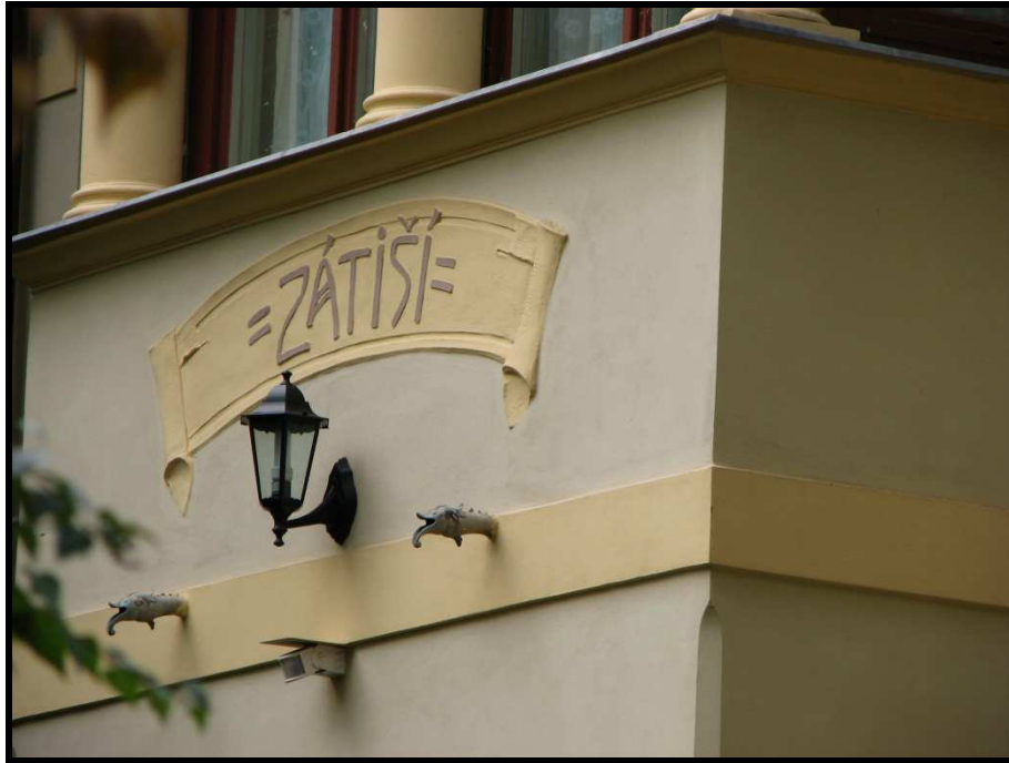
Obr. č. 11 Na fasádě domu č. 31 zůstal dochovaný nápis.
