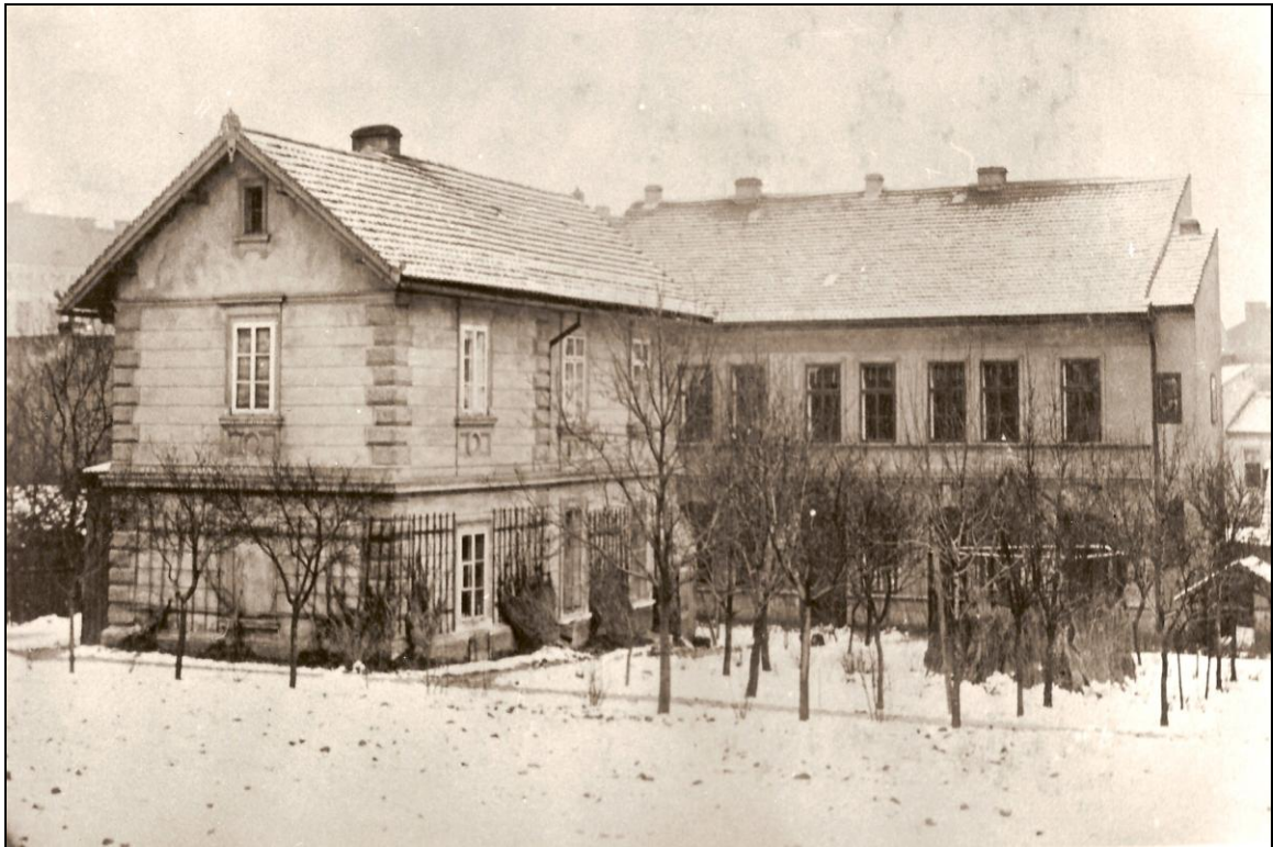
22. Budova Vincentina v Praze-Holešovicích do roku 1899.
