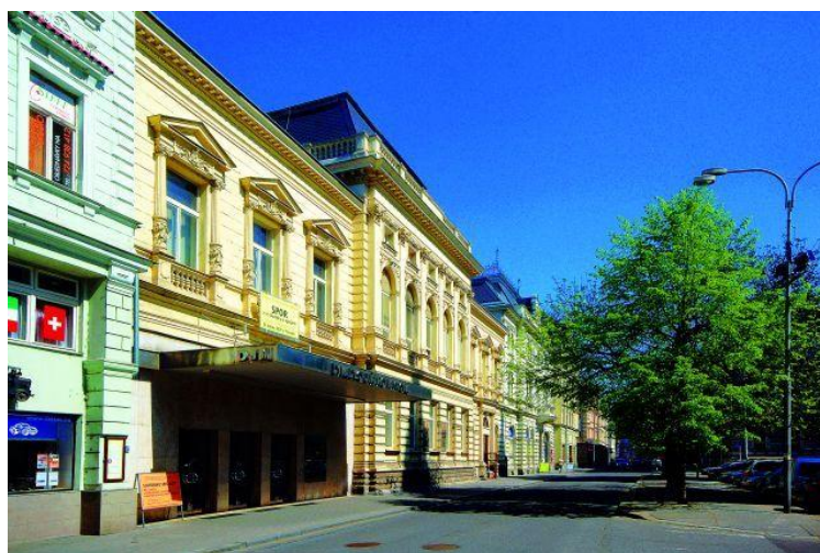
18. Divadlo Jiřího Myrona v Ostravě, průčelí zachovávající původní stav
