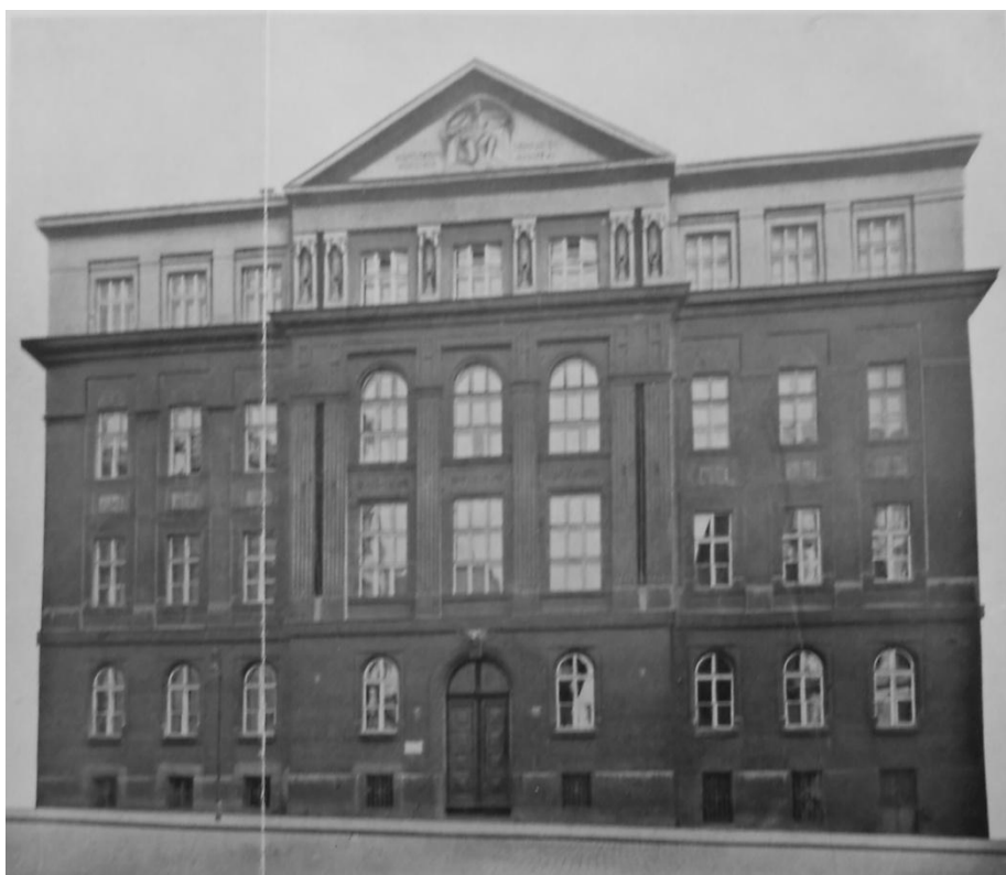
Budova Československé akademie obchodní v Resselově ulici v Praze po přístavbě třetího patra v r. 1915
