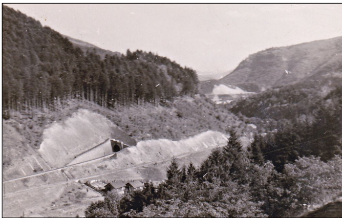
Obr. 33: (6.9.) Na cestě z Vrútek do Března nad Hronom. Tunely před Ulmankou
