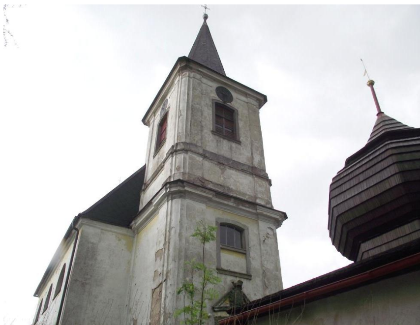
34. Bartošovice v Orlických horách , kostel sv. Máří Magdalény, 1673, přestavba 1731–1746, pohled od severozápadu
