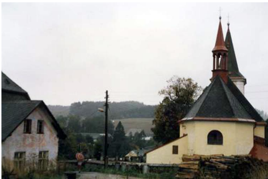
23. Bartošovice v Orlických horách , kostel sv. Máří Magdalény, 1673, přestavba 1731–1746, stav v roce 1993, pohled od východu
