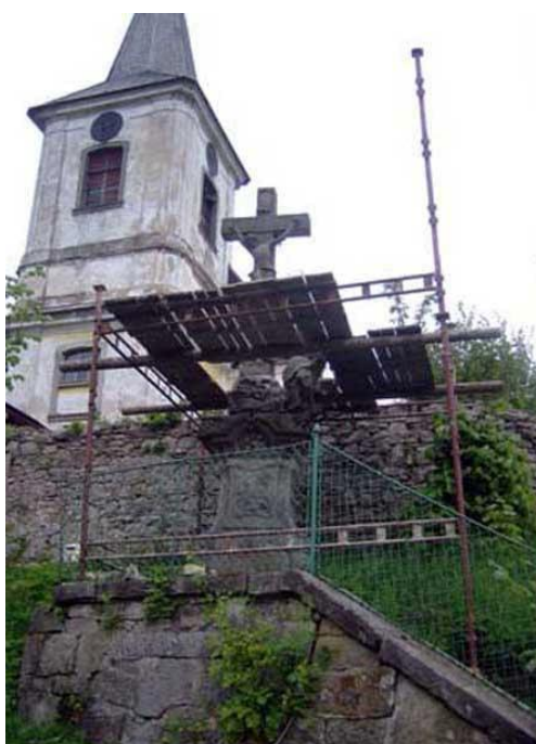
29. Bartošovice v Orlických horách , Kalvárie, 1793, stav při rekonstrukci v roce 2009, pohled od jihozápadu
