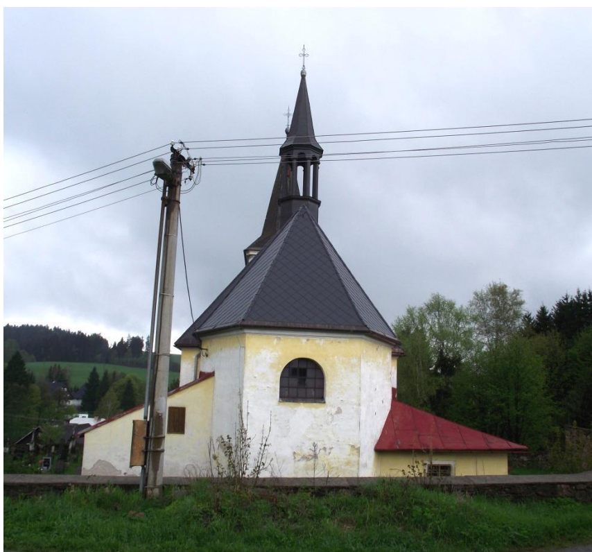
35. Bartošovice v Orlických horách , kostel sv. Máří Magdalény, 1673, přestavba 1731–1746, pohled od východu
