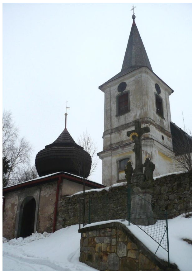
33. Bartošovice v Orlických horách , kostel sv. Máří Magdalény, 1673, přestavba 1731–1746, pohled od jihozápadu
