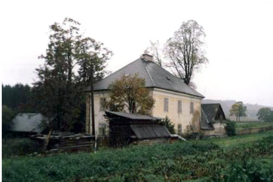
39. Bartošovice v Orlických horách , fara, 1746, přestavba 1840, stav v roce 1986, pohled od jihovýchodu
