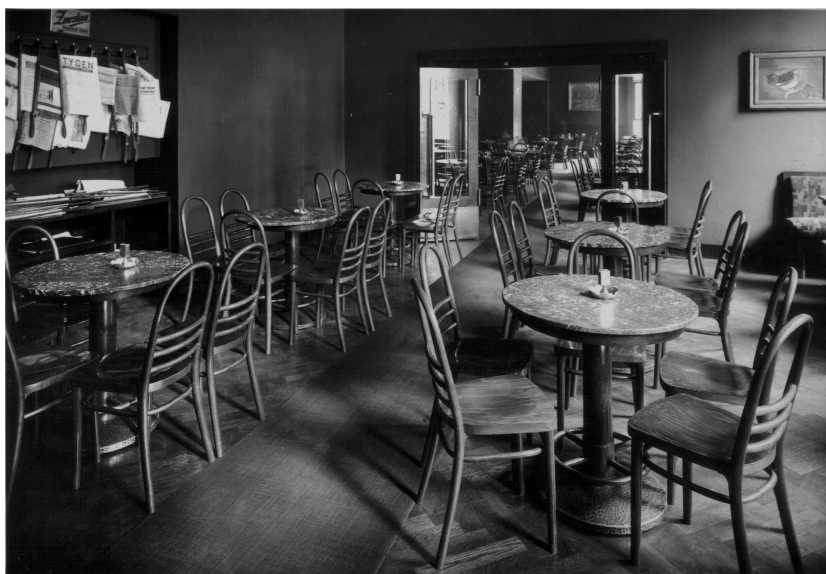
[16] Kavárna Metro, Národní čp. 961, Praha, interiér předního traktu, 1928
