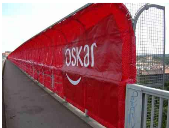
Obrázek 21 Pokrytý Nuselský most reklamou telefonního operátora. Zdroj: http://mobil.idnes.cz/zavrete-oci-oskar-odchazi-vzpominame-na-jeho-reklamy-pc5-/mobilni-operatori.aspx?c=A060116_182512_mob_operatori_hro
