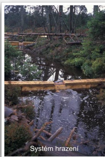
Foto 5: Hrazení odvodňovacích kanálů
