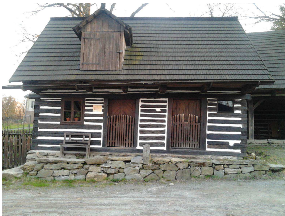
1. Expozice lidového stavitelství Veselý Kopec. Výměnek s chlívkem, autor K. Kábelová.
