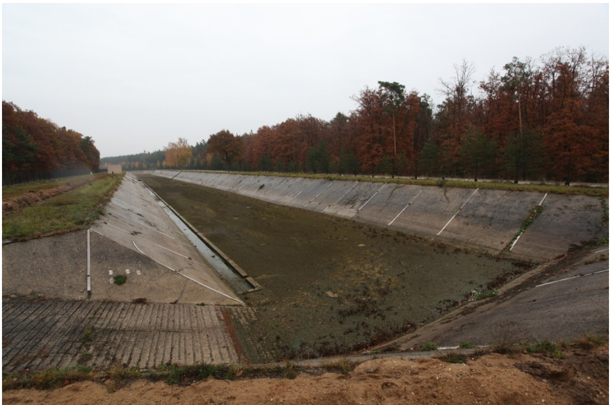
Obr. č.8: Vsakovací nádrže umělé infiltrace v ÚV Káraný (commons.wikimedia.org; 20.7.2013)
